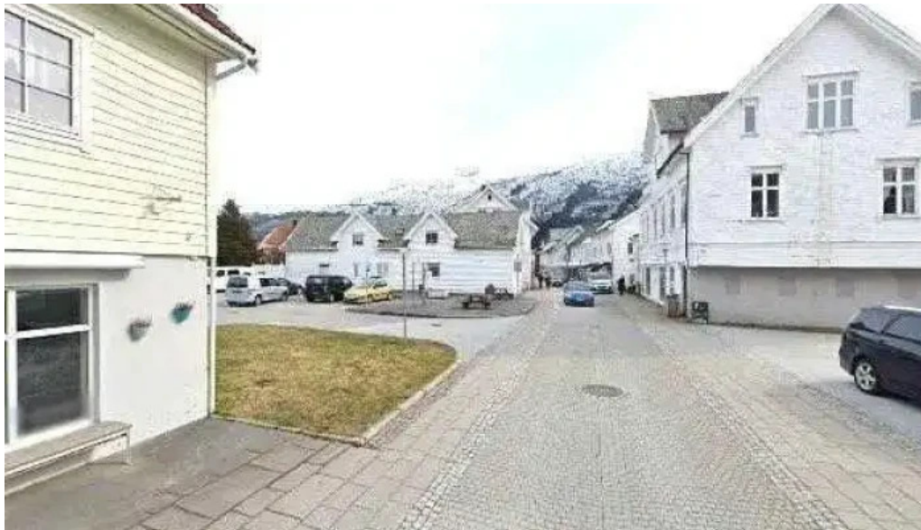
Objektsikring da avd eid alle
