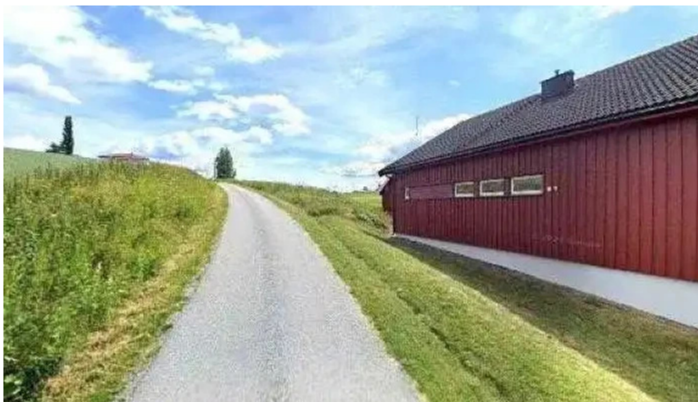
Fjellfoten renseanlegg alle
