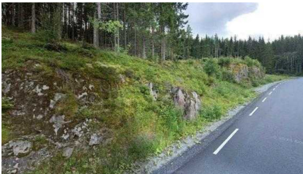
Synspunkt kviteseidvegen street view 360deg
