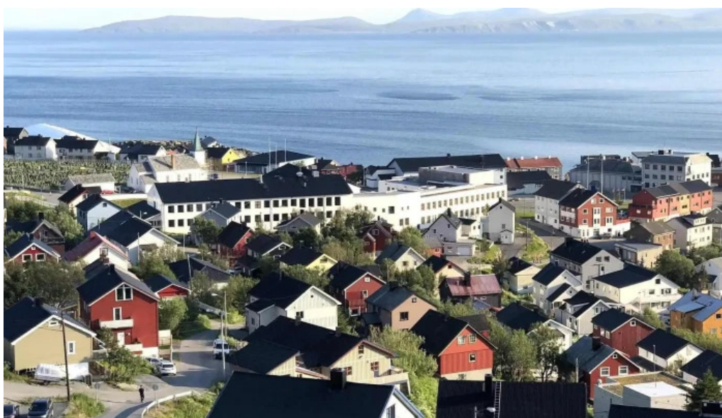
Honningsvåg skole skole
