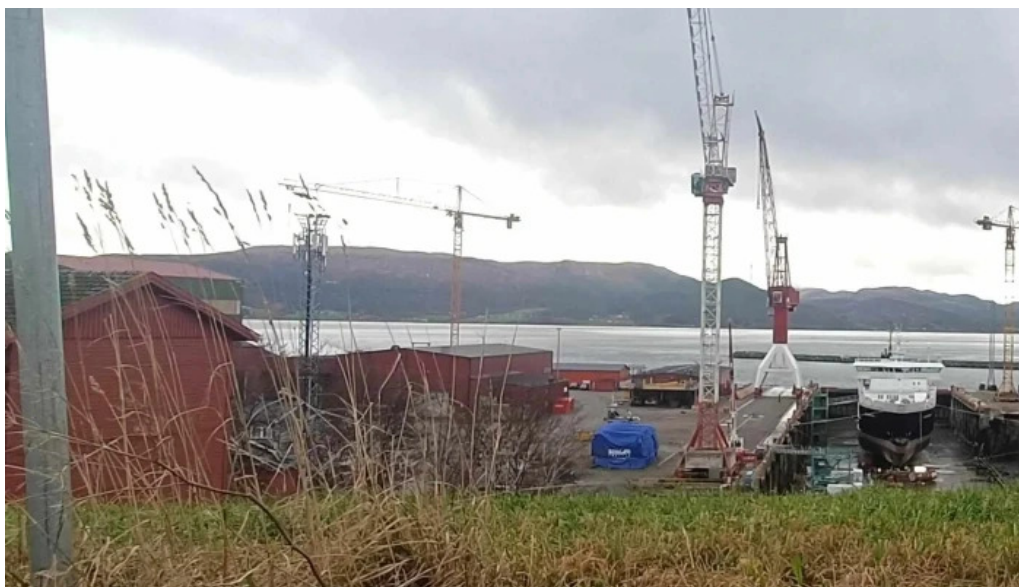
Fosen yard skipsverft
