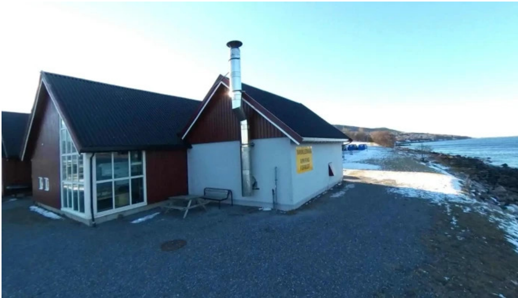
Alstahaug kommune street view 360deg
