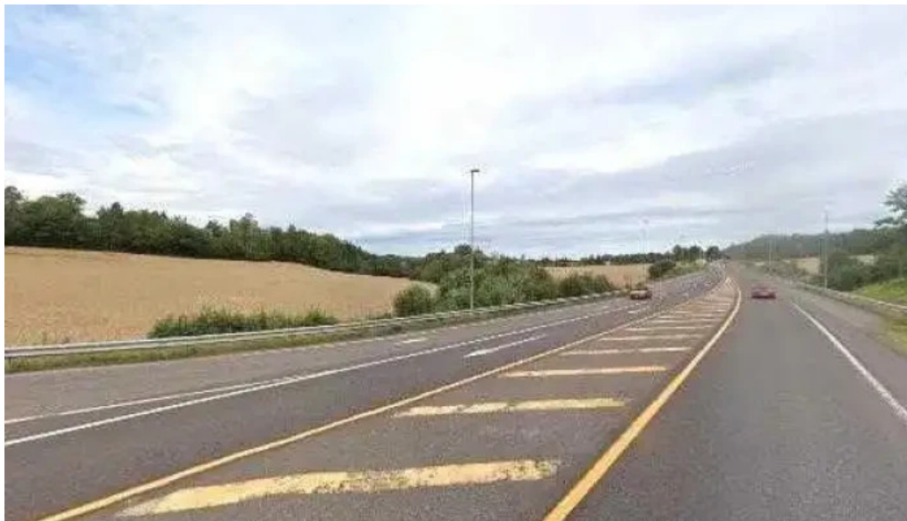
Skoppum gjenvinningsstasjon vesar street view 360deg
