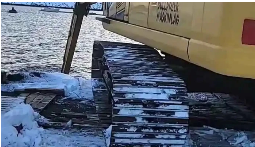
Kystverket kabelvåg videoer
