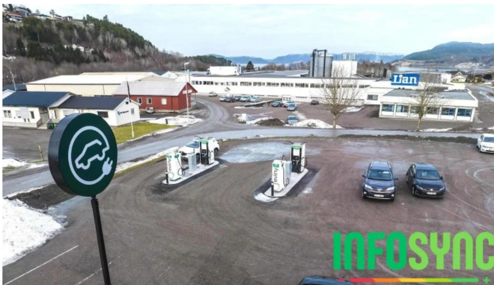
Eviny ladestasjon alle
