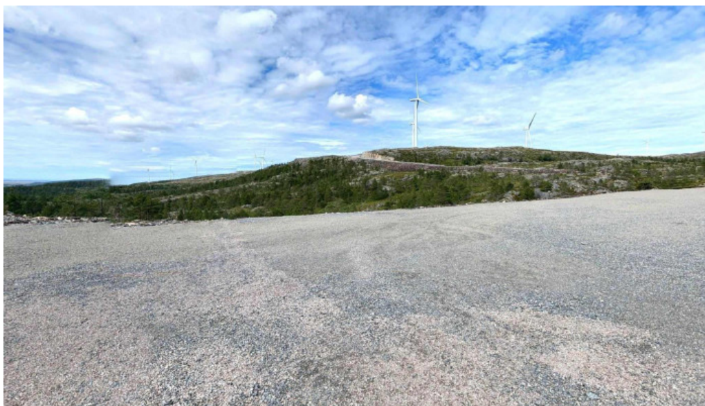
Hitra vindkraftverk street view 360deg
