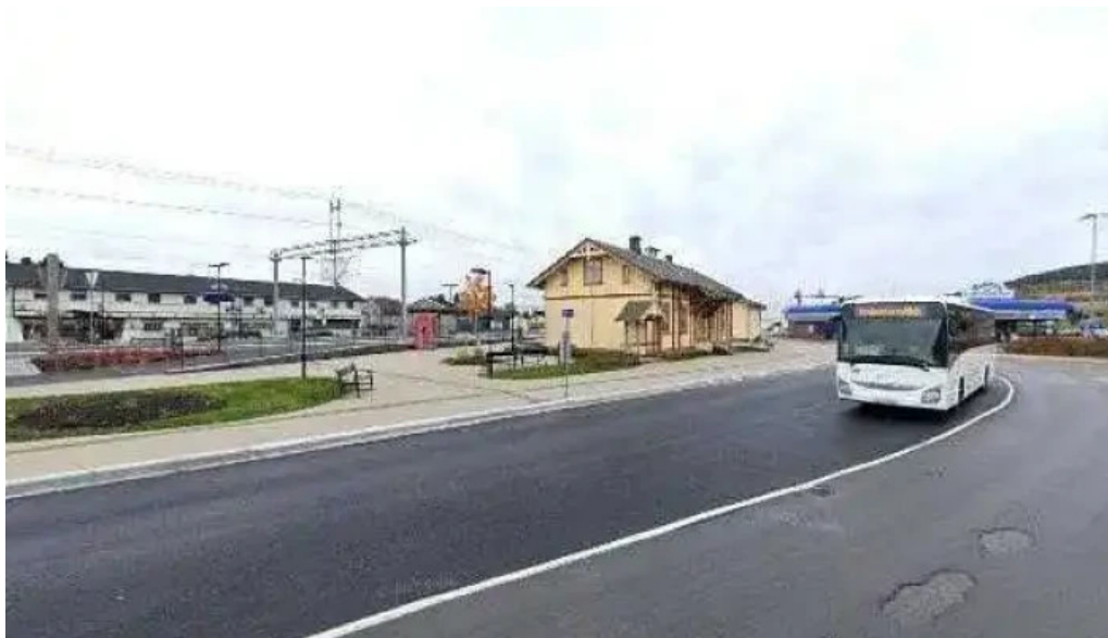
Skarnes stasjon street view 360deg
