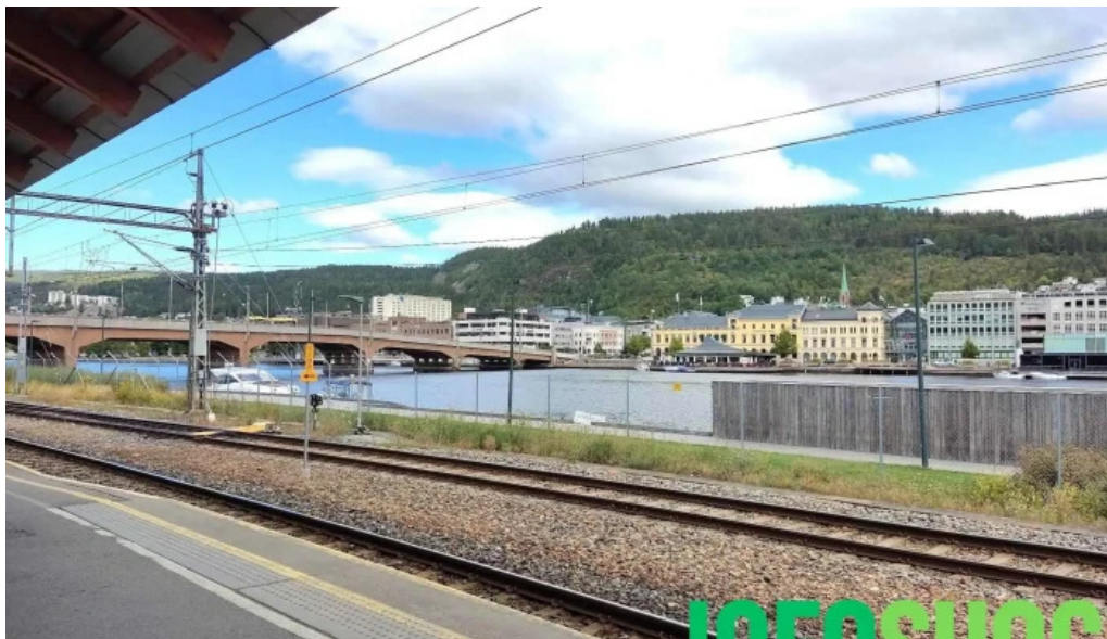
Drammen stasjon jernbanestasjon
