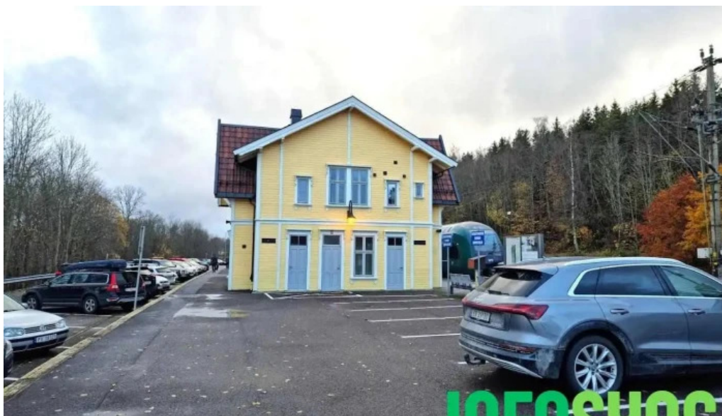
Skoppum stasjon skoppum
