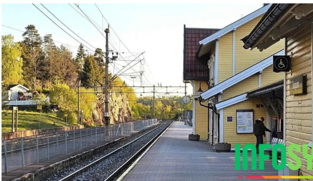
Skoppum stasjon sist opplastet
