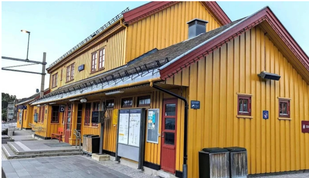
Geilo stasjon jernbanestasjon
