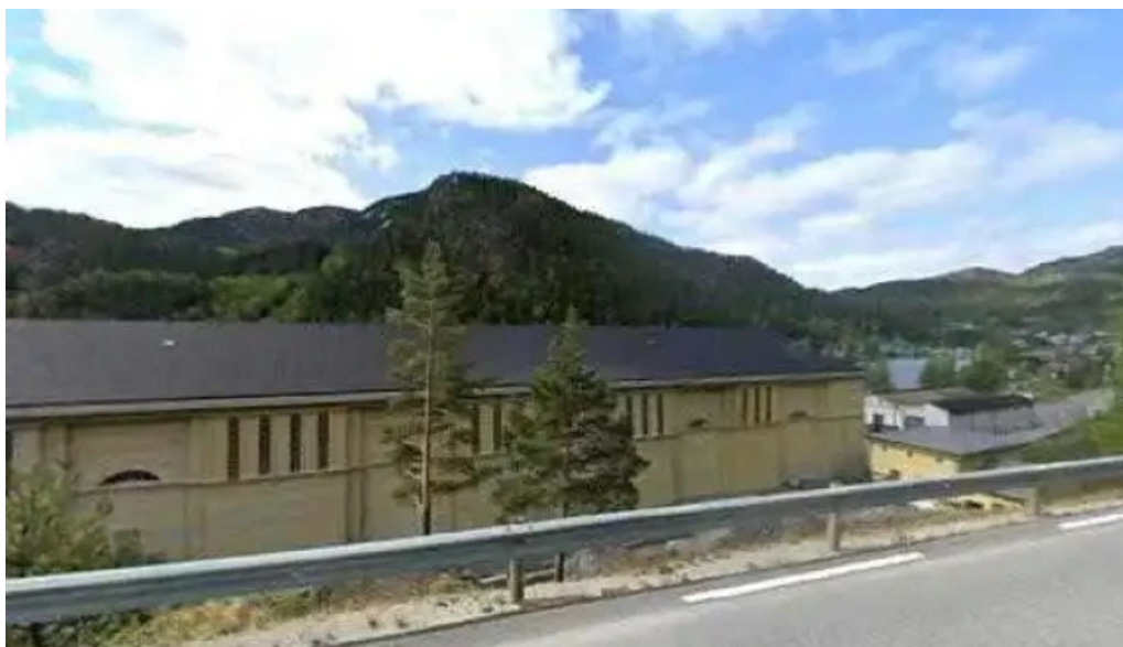
Nore i kraftstasjon street view 360deg
