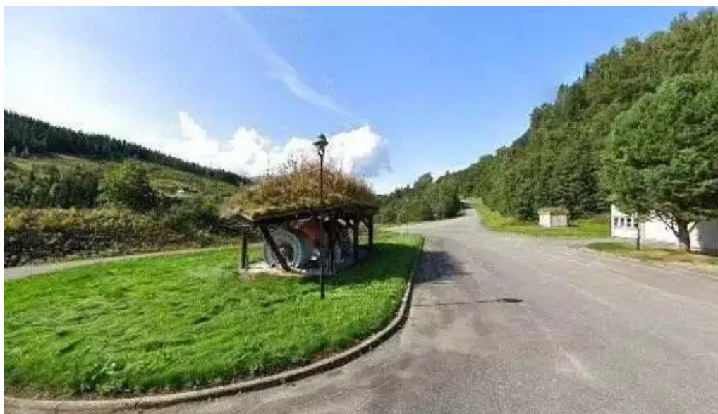
Meraker kraftverk alle
