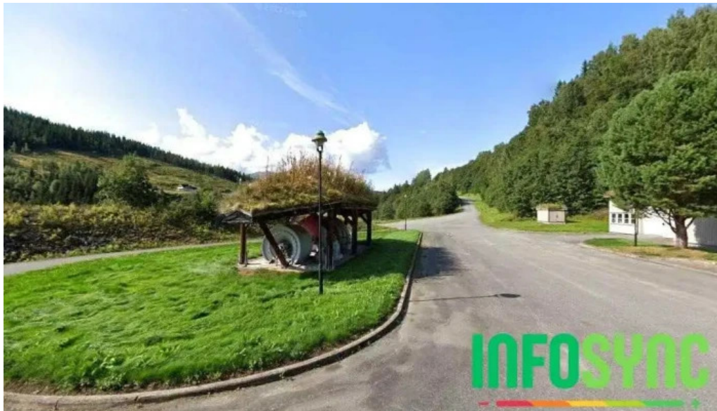
Meråker kraftverk meråker
