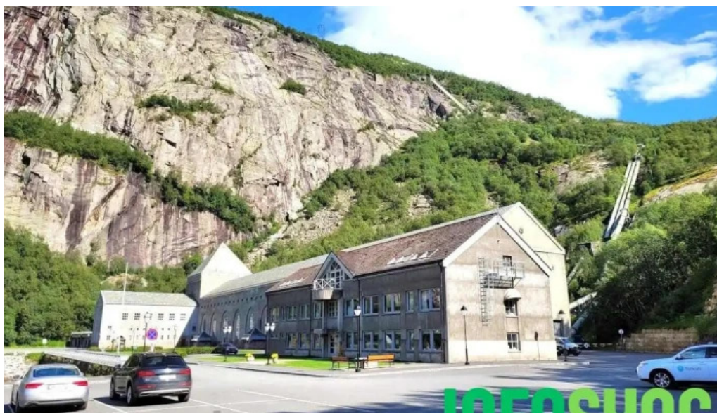
Glomfjord kraftverk glomfjord
