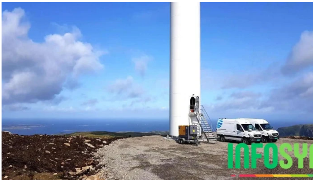
Roan vindpark servicebygg einarsdalen brandsfjord
