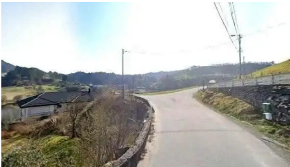
Nordhordland fjellsprenning as alle
