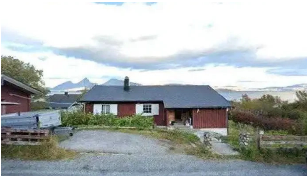
Abt alstahaug byggteknikk as street view 360deg
