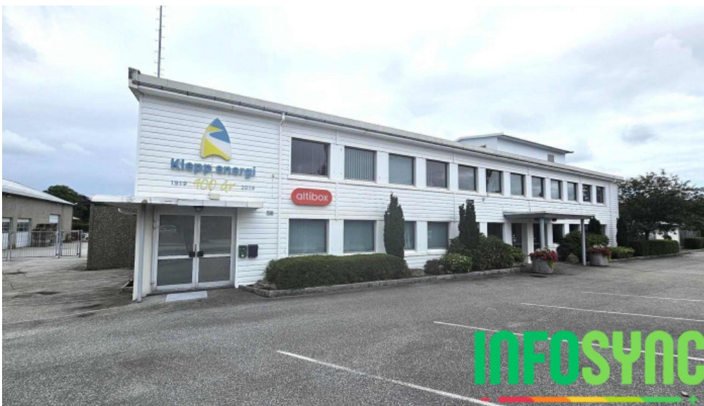
Klepp energi kleppe
