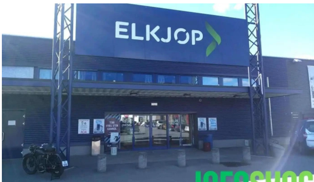
Elkjøp drammen drammen
