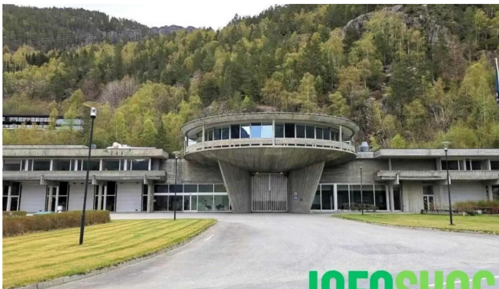
Hydro energi røldal suldal nesflaten
