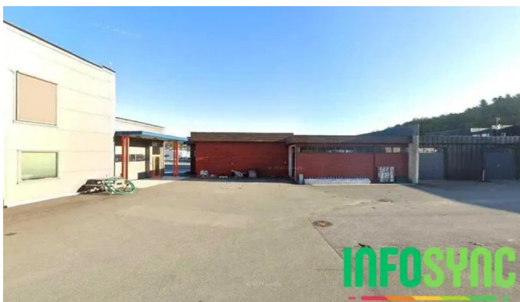
Fosenkraft elektro as botngård
