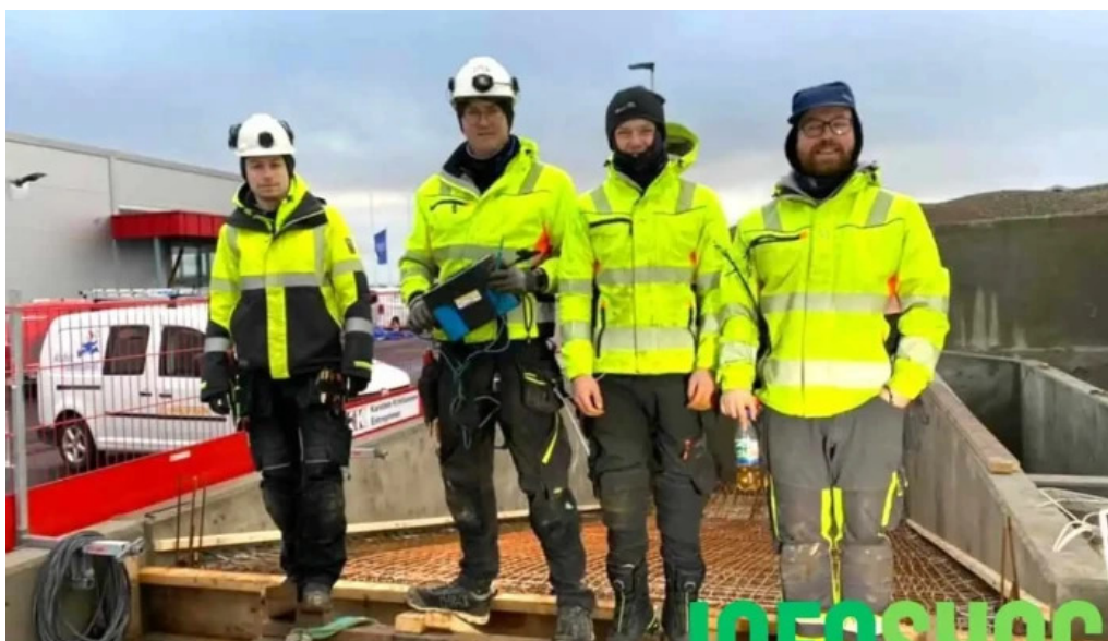
Andøy installasjon as andenes
