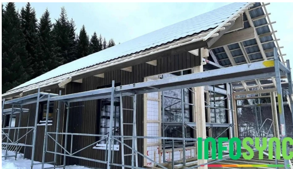
Lavangen bygg as tennevoll
