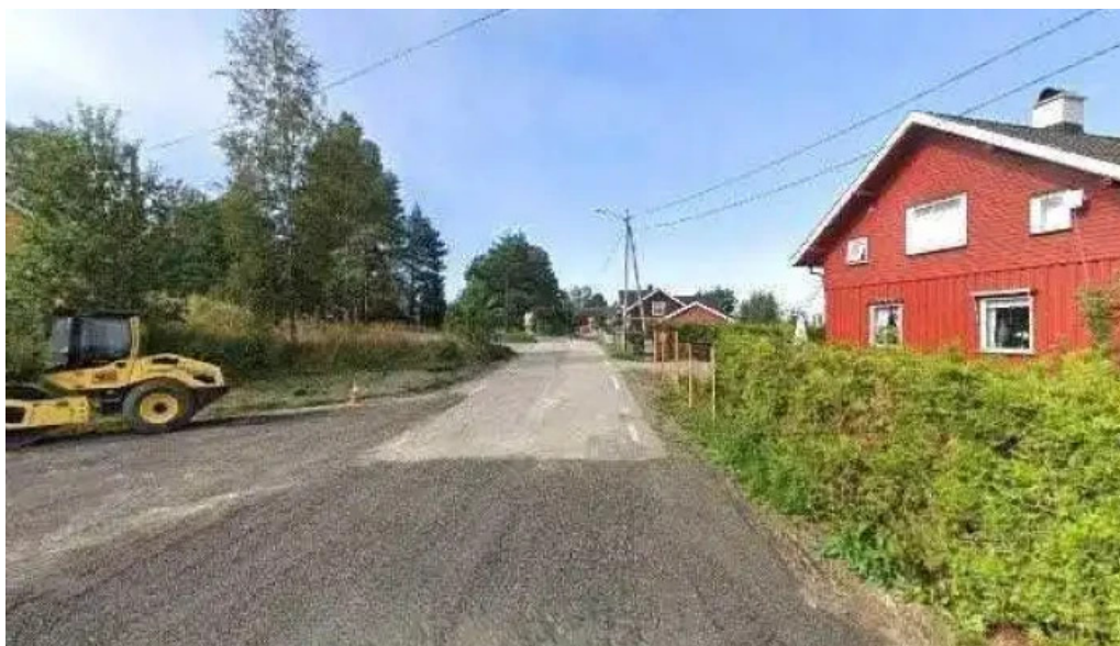
Eidsberg stasjonsveien alle
