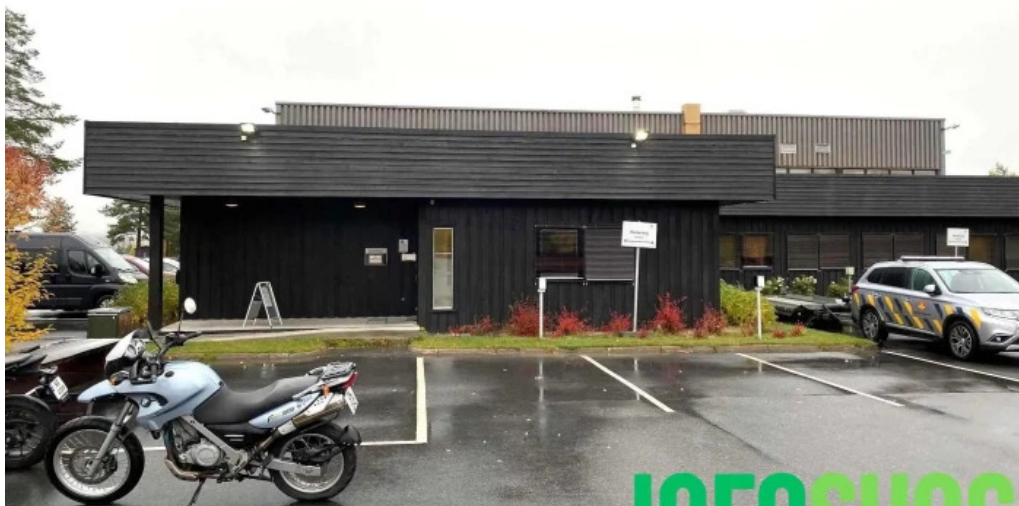
Statens vegvesen tynset trafikkstasjon parkeringsplass
