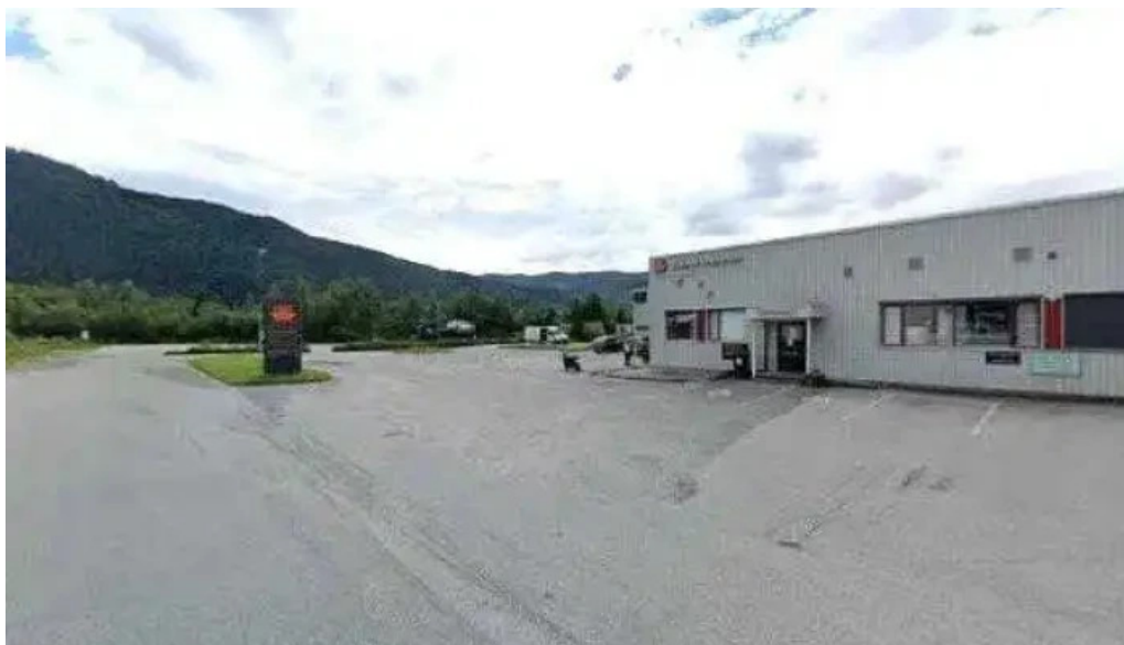
Statens vegvesen orkdal trafikkestasjon street view 360deg
